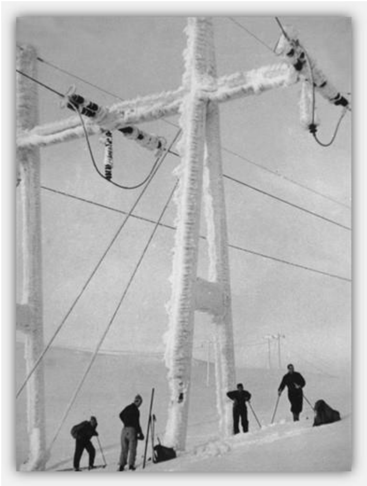
The power line Nedre Vinstra – Fåberg – Oslo:
