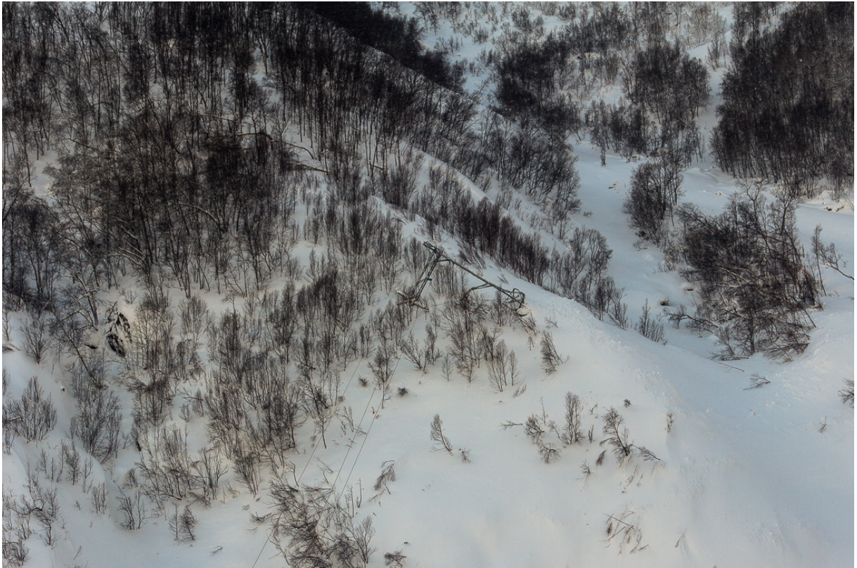
Figur 14: Mast på 132 kV Narvik – Skjombotn, skadet februar 2015 (Bilde Arni Jonsson, NGI)
