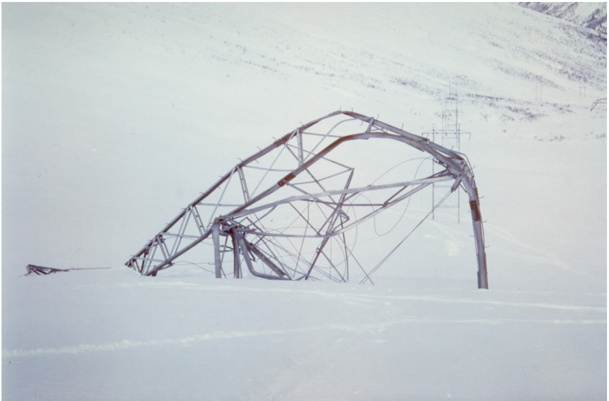
Figur 15: Mast revet ned av skred nord for Helvetestinden ved Risbrekka der 16 master havarerte i 1987 .
